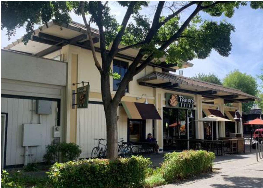
West façade, ESA 2022.
